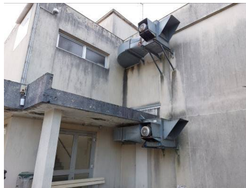
Gaines extérieures + extracteurs de désenfumage chambres Bât 22
